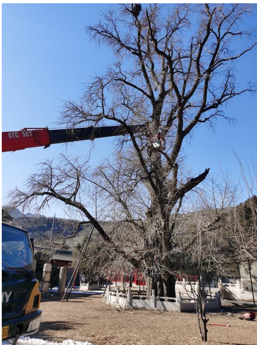
中央国家机关一号树保护工程正式开工
